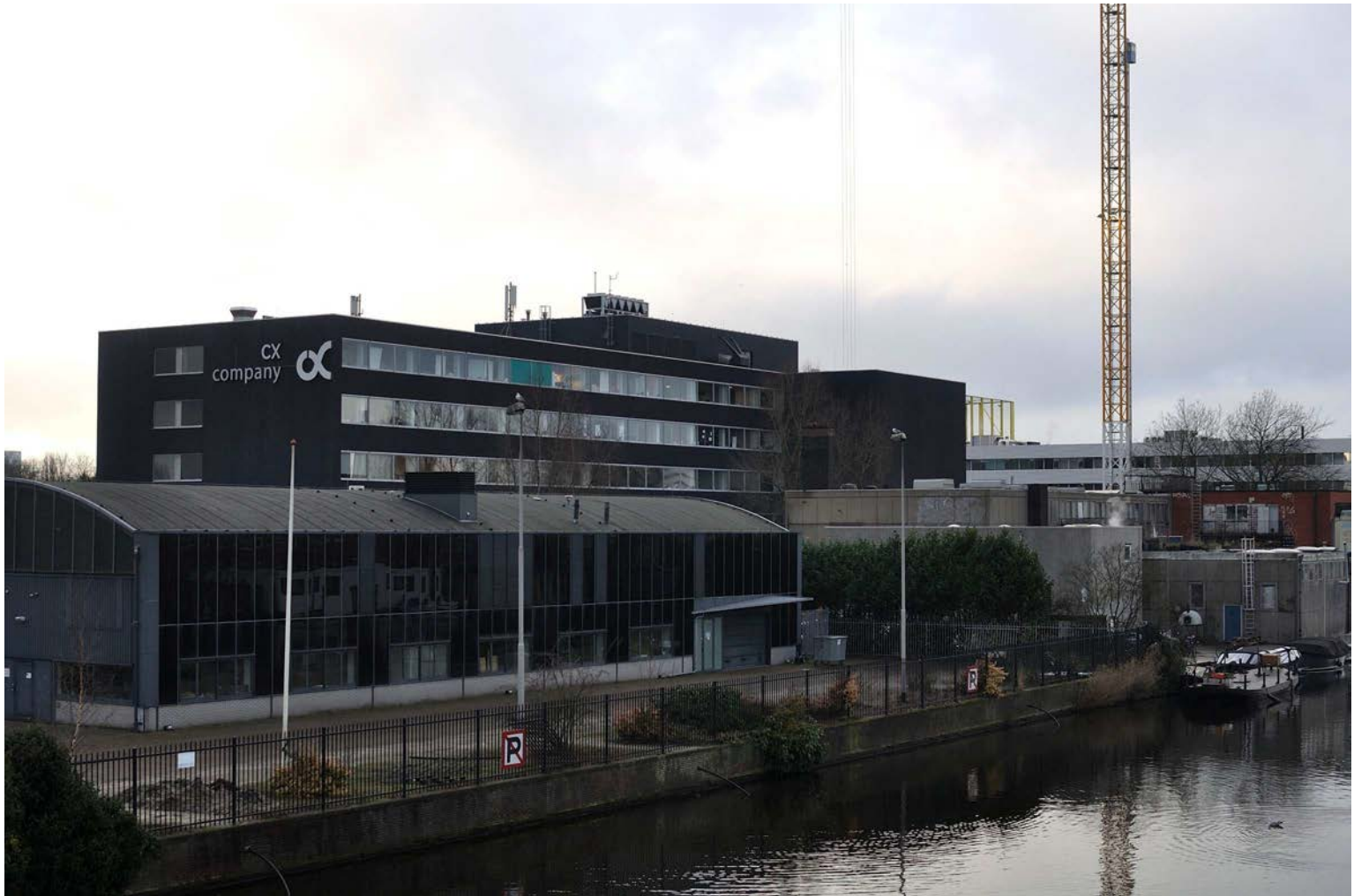
Duivendrechtsevaart, CX Company Renovatie Mulders van den Berk, 2014
